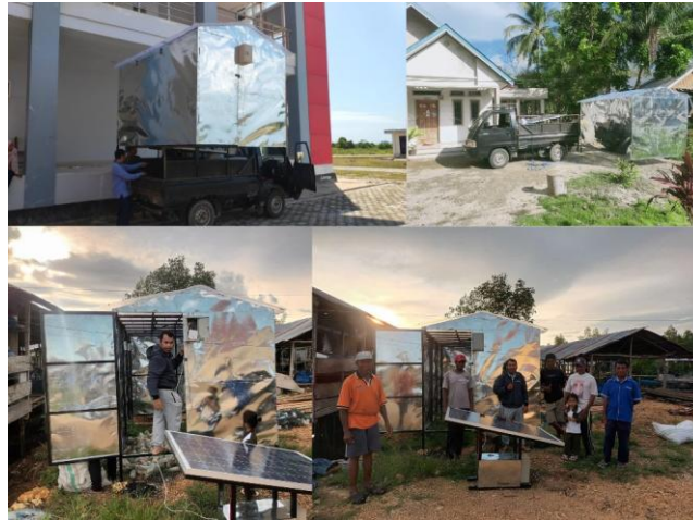
Gambar 7. Proses instalasi teknologi di lokasi
